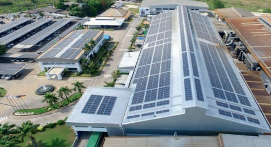
Панелі на фотоелементах, встановлені на даху фабрики в Клаенгу, скорочують викиди CO 2 майже на 2000 тонн щороку
